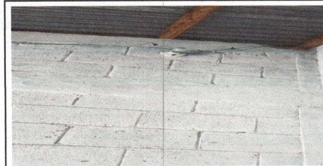
Foto 6: Reparación del sistema eléctrico
