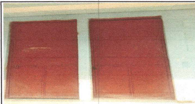
Foto 2: Sustitución de puerta
