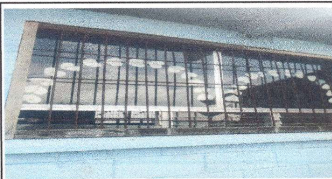
Foto 3: Sustitución de estructura de metal de ventana
